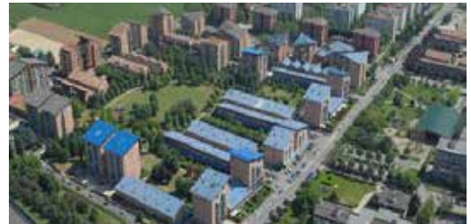
Tetti Blu, Alba - 2.000 m 2 di CGL 20cy Riqualificazione energetica
