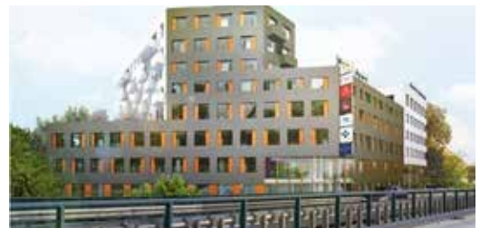
Centro Globis, Breslavia 4.500 m 2 di CGL 20cy Riqualificazione energetica e protezione dal fuoco
